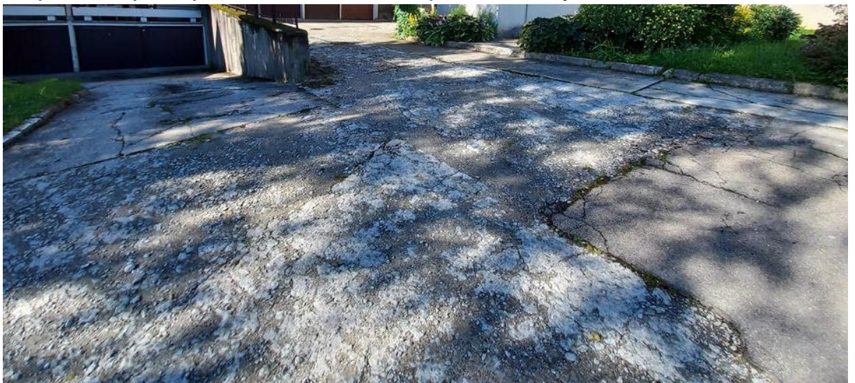
Miejsce do wymiany nawierzchni betonowej na asfaltową
